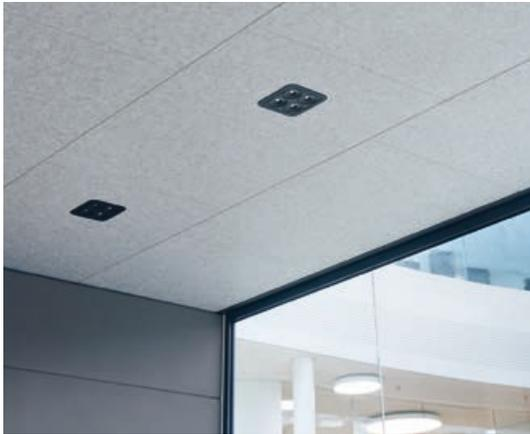
I pannelli in feltro PET sul soffitto e la parete tecnica completamente isolata migliorano il tempo di riverbero del sistema room in room.
